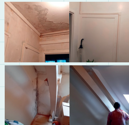
Avant/après l'intervention du dispositif ADEL de logements du parc privé très dégradés.
